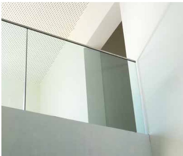
Un'installazione di parapetto GLASSU a pavimento - A floor anchor installation of a GLASSU railing
